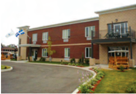
Centre régional et Hôtellerie de l'Outaouais 580 résidents
